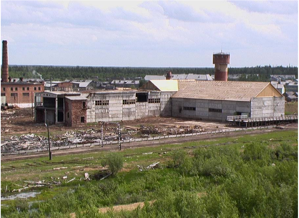
Здание лесопильного цеха (справа) с эстакадой для подачи кругляка и нулевой цикл под сушилку и цех глубокой переработки (слева).
